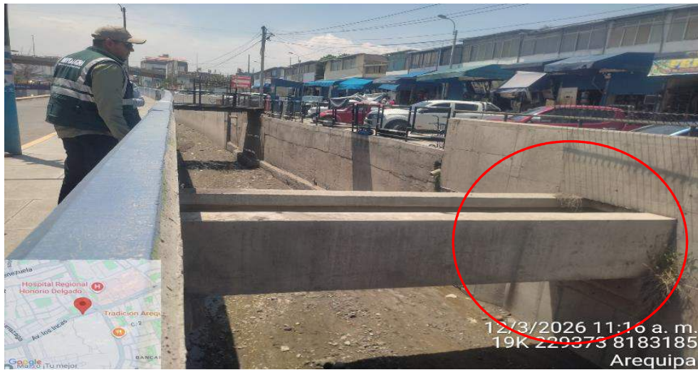
FIGURA N°02: SE MUESTRA LA ALTURA DEL PASE DEL CANAL, EN UNA MAXIMA AVENIDA PUEDE IMPEDIR EL PASO EL AGUA OCASIONANDO INUNDACION AGUAS ABAJO
