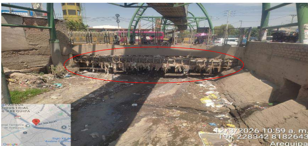
FIGURA N°04: SE OBSERVA EL FINAL DEL TRAMO AGUAS ABAJO QUE EXISTE UNA TUBERIA Y UN PUENTE QUE IMPIDEN EL PASO DEL AGUA DESBORDANDOSE AGUAS ABAJO Y AFECTANDO PARTE DEL TERMINAL TERRESTRE
